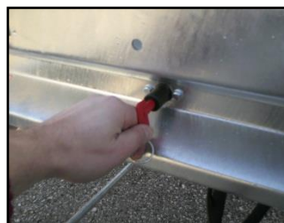
Bild 8: Hauptschalter auf AUS gestellt
