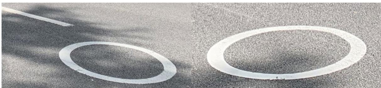
ABBILDUNG 14: B 56, km 7,70, Sondermarkierung Ellipsen; ausgewählte Ellipsen etwa auf Höhe des Kurvenscheitels
