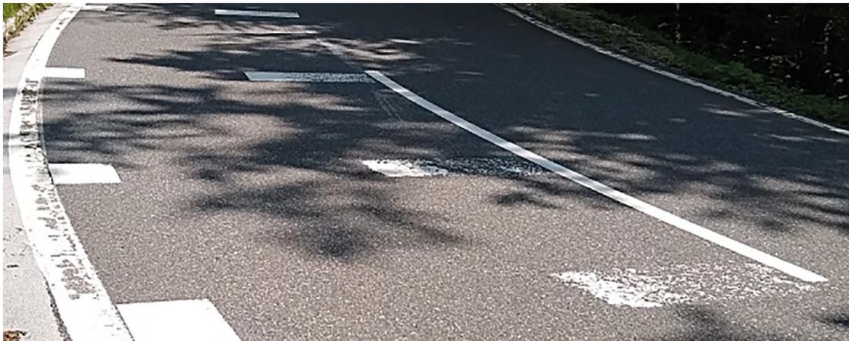
**ABBILDUNG 18:** B 21, km 62,30: Die letzten drei Balken in Fahrtrichtung, innen zirka auf Höhe des Kurvenscheitels, wurden stark abgefahren.
