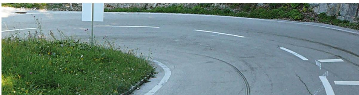
ABBILDUNG 30: B 91: Fehlende Sondermarkierung am Kurvenscheitel und Kurvenausgang
