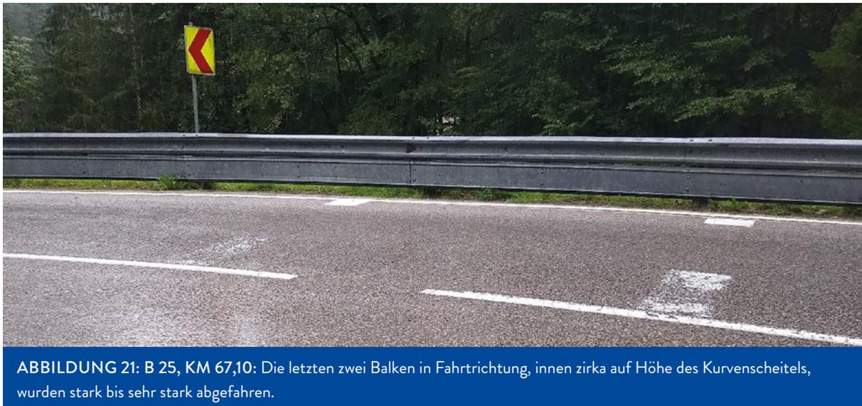
An dieser Kurve wurden die Leitschienen an der Kurvenaußenseite bereits mit einem Unterfahrschutz versehen. Mittels eines Unterfahrschutzes können Leitschienen entschärft werden. Es handelt sich dabei um eine passive Maßnahme zur Verbesserung der Verkehrssicherheit. Speziell hinsichtlich der Motorradfahrenden kann damit die Unfallschwere verringert werden (Schutz vor Anprall an Leitschienenpfosten sowie vor Durchrutschen und Anprall an sekundäre Hindernisse).
