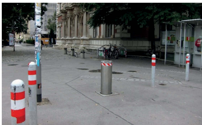
Abbildung 21: Versenkbarer Poller als Zufahrtshindernis für unbefugte Personen
