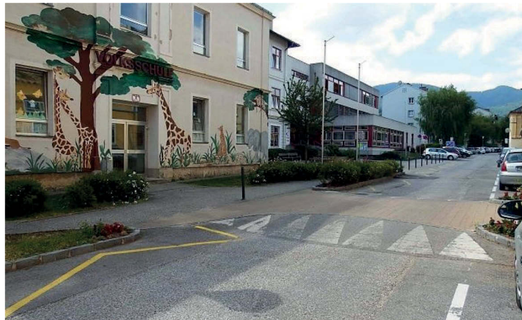
Abbildung 27: Gelb gepflasterte Fahrbahnanhebung direkt vor dem Eingang der Volksschule
