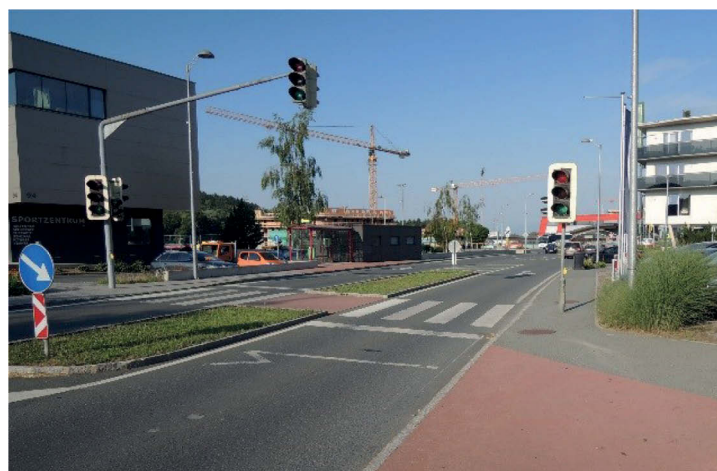
Abbildung 18: Schutzweg mit VLSA, Mittelinsel, Fußgängeranmeldung und farblicher Oberflächengestaltung
