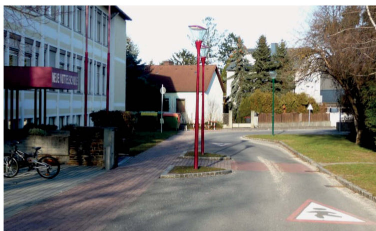
Abbildung 25: Ein Fahrbahnversatz kann auch durch einfache Mittel hergestellt werden
