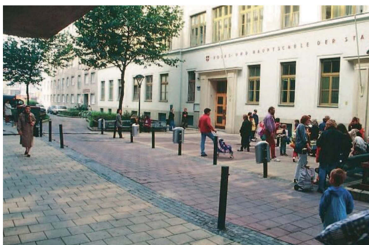
Abbildung 29a / 29b: Fahrbahnanhebungen vor der Schule im Verein mit Wohnstraßen, Begegnungszonen oder Aufenthaltsflächen sind besonders wirksame Maßnahmen
