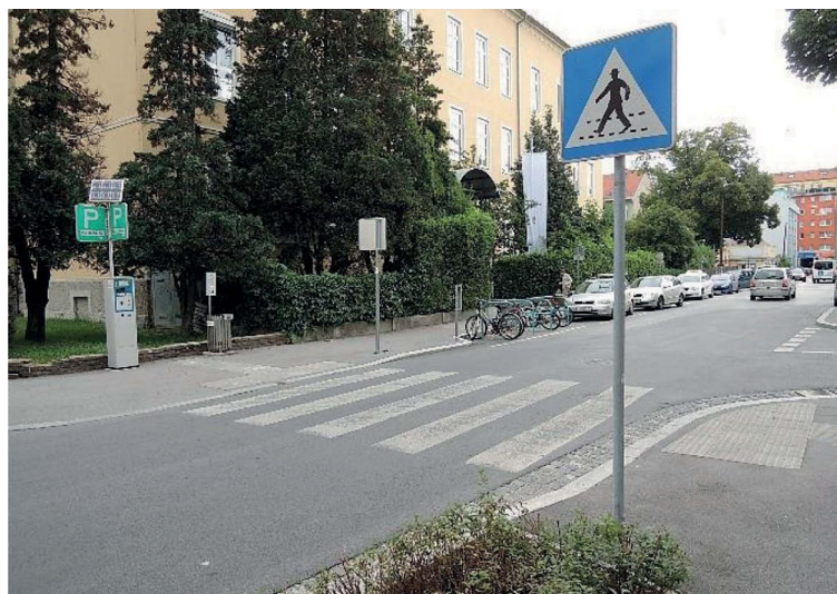
Abbildung 44: Taktiler Leitsystem beim angrenzenden Schutzweg
