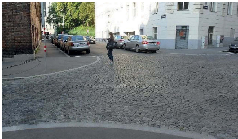
Abbildung 28: Plateauanhebung im kompletten Kreuzungsbereich sorgt für klare Verhältnisse und eine bequeme Querung dieser Kreuzung
