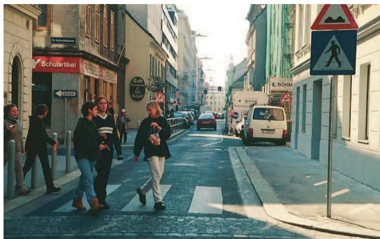
Abbildung 26: Der Schutzweg wird durch die Anhebung des Niveaus unterstützt; Poller verhindern die Sichteinschränkung durch illegale Parker
