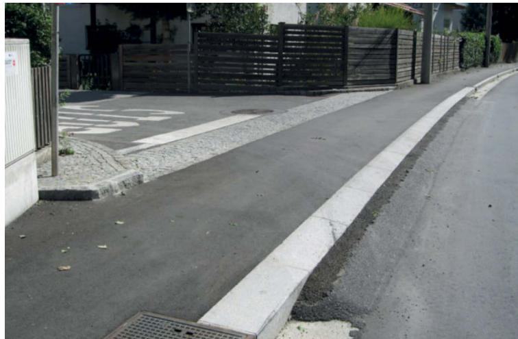
Abbildung 33: Gehsteige sollten auf einem Niveau durchgezogen werden; der Kfz-Lenker muss die Geschwindigkeit senken, was kürzere Anhaltewege zur Folge hat (Foto: Brunner)
