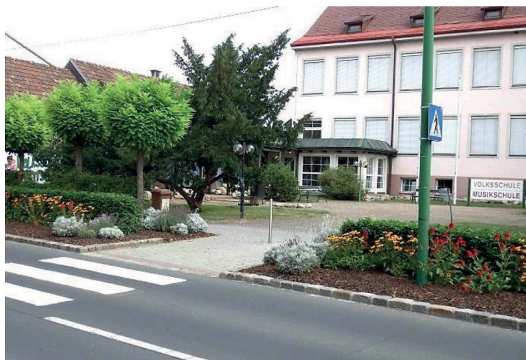
Abbildung 22: Gehsteigvorziehung beim Schutzweg mit niedriger Bepflanzung
